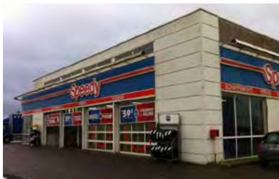
Avant travaux, VINEUIL (41).
