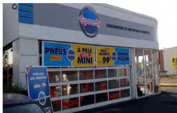
Après travaux, VINEUIL (41).
